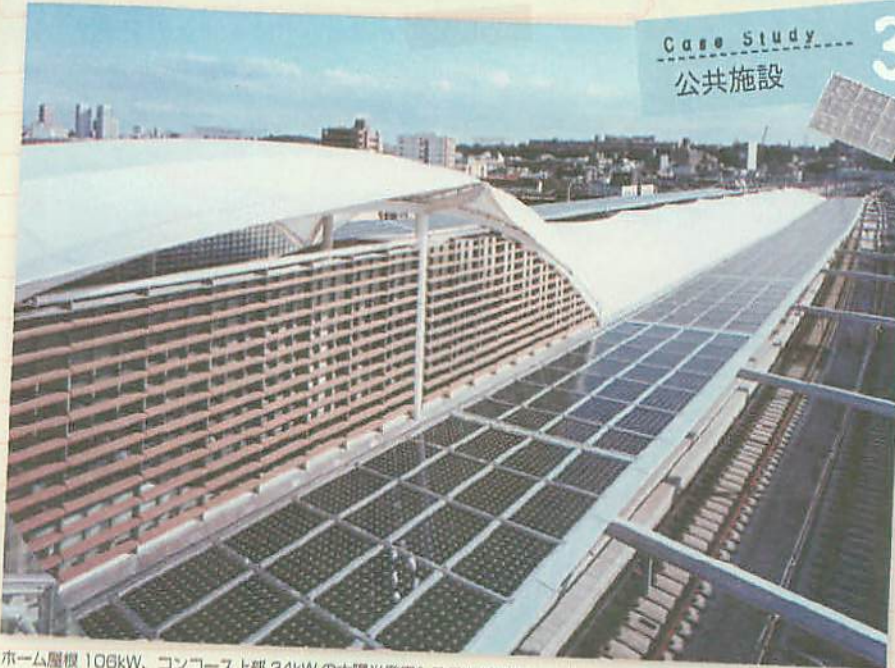
ホーム屋根 106kW、コンコース上部 34kWの太陽光発電システムが導入されている。
