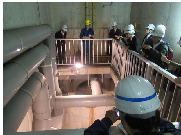
名古屋市 東山浸雨水貯留施設
