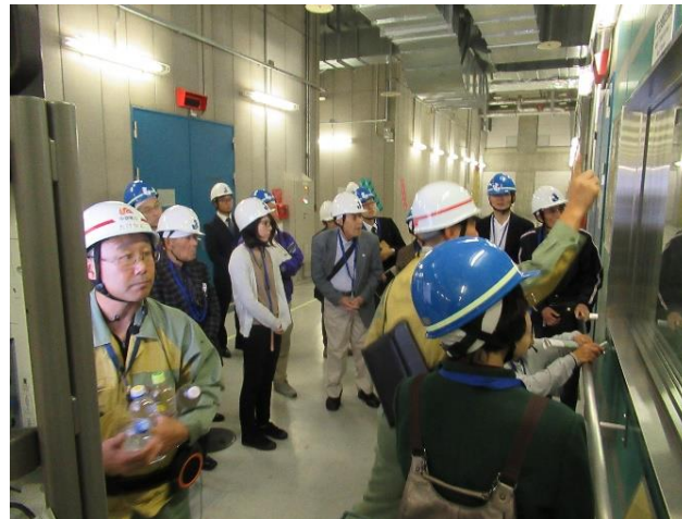
中部電力 名城変電所
