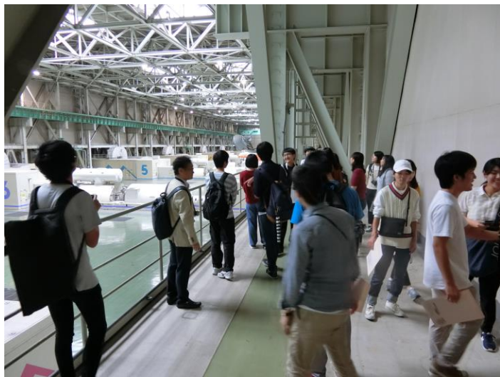
川越火力発電所
